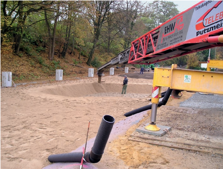
Abbildung 2: Einbau des Bodenfiltersandes auf der Drainagezone. Im hinteren Teil der Anlage wird bereits das Pflanzgranulat ausgebracht.
